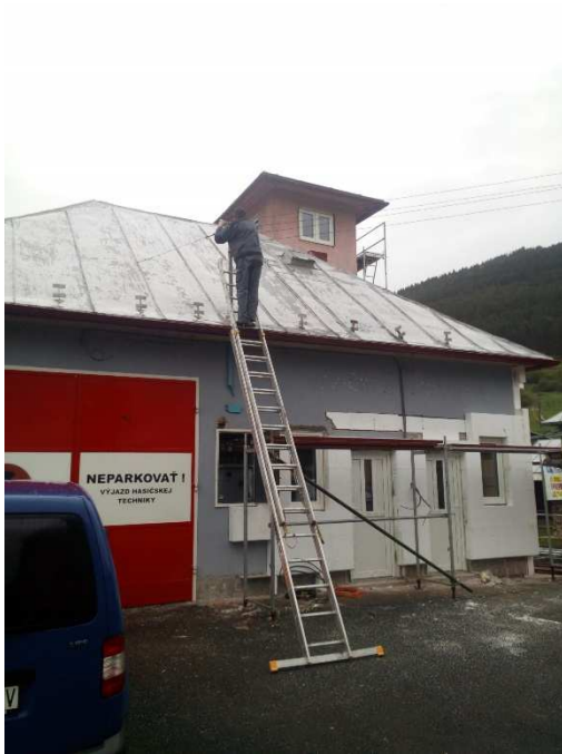
Rekonštrukčné práce v roku 2019 na požiarnej zbrojnici
